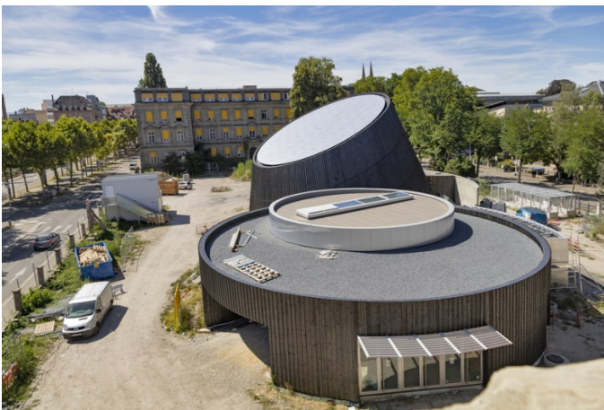
Le nouveau Planétarium boulevard de la Victoire. Avancée des travaux en juillet 2022 ©Catherine Schröder / Unistra
