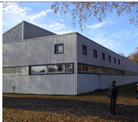
Vue du hall technologique avant travaux
