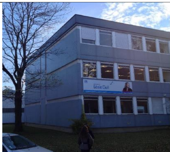
Vue du bâtiment d'enseignement avant travaux
