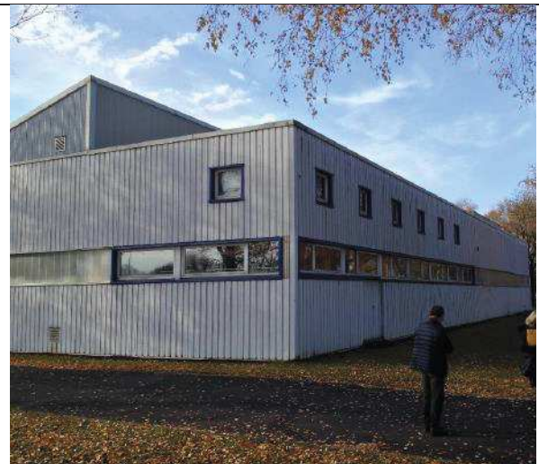
Vue du hall technologique avant travaux
