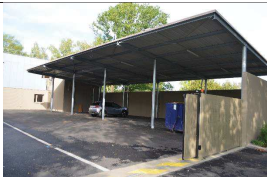
Vue du préau de stockage attenant au hall
