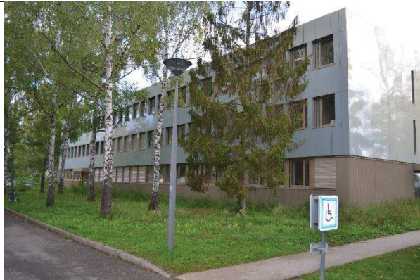
Vue du bâtiment GC d'enseignement rénové
