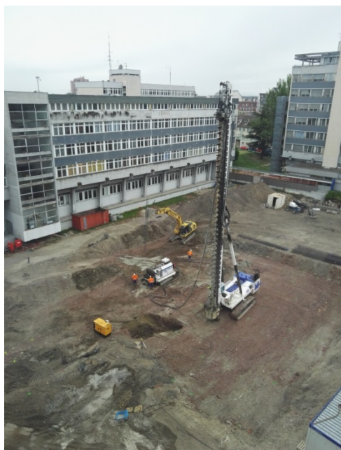
Avril 2017 : Premières fondations profondes @E Saint-Dizier
