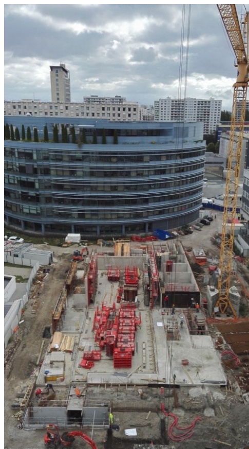
Septembre 2017 : Phase Gros-Œuvre Réalisation des voiles béton du rez-de-chaussée @E Saint-Dizier
