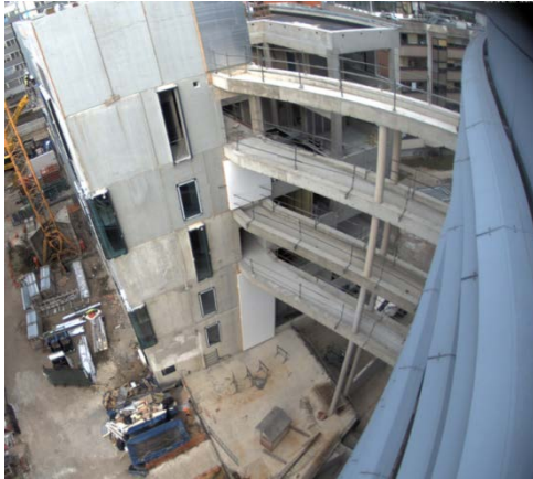
Septembre 2018 : Réalisation des passerelles @E Saint-Dizier
